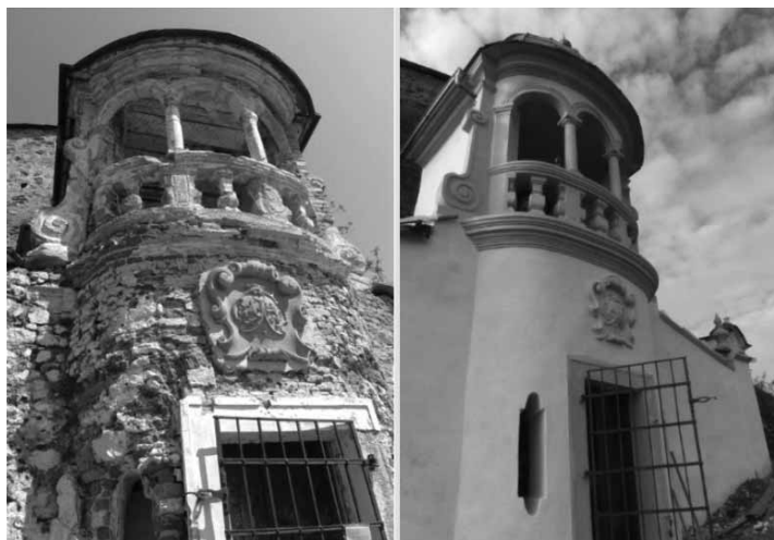
Pred a po rekonštrukcii kaplnky Ecce Homo FOTO ARCHÍV KF
