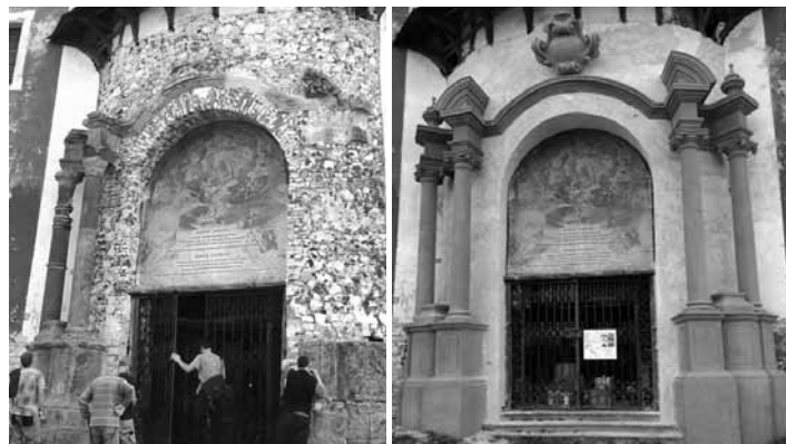
Pred a po rekonštrukcii portálu Horného kostola FOTO ARCHÍV KF
