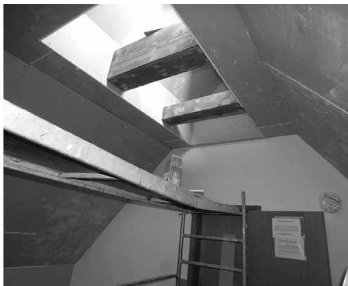
Montáž sadrokartónového obalu v podkroví FOTO J. CHRENKO 33.str.
