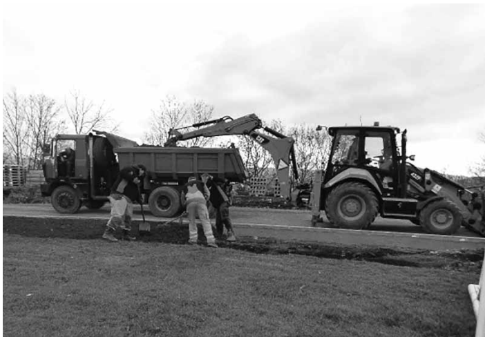
Realizácia odvodnenia dráhy FOTO JURAJ CHRENKO
