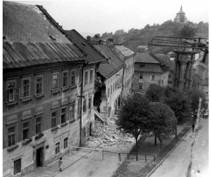
Pohľad na zrútené stropy a fasády Richterovho a Jonášovho domu, koniec 60. rokov 20. storočia FOTO ARCHÍV SBM
