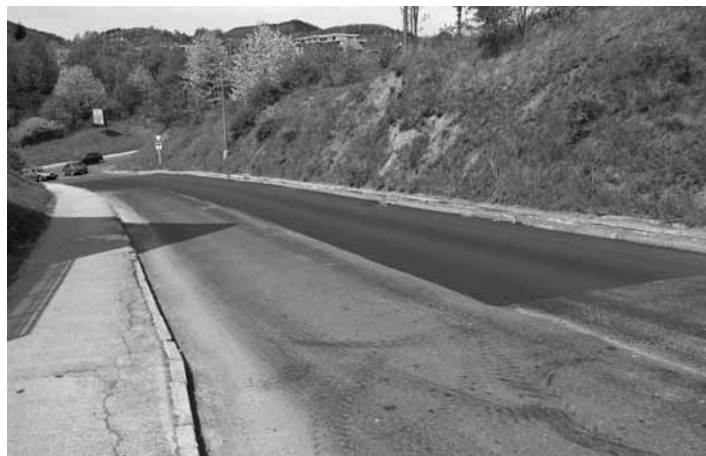
Nový asfaltový povrch na sídlisko Drieňová FOTO MICHAL KRÍŽ
