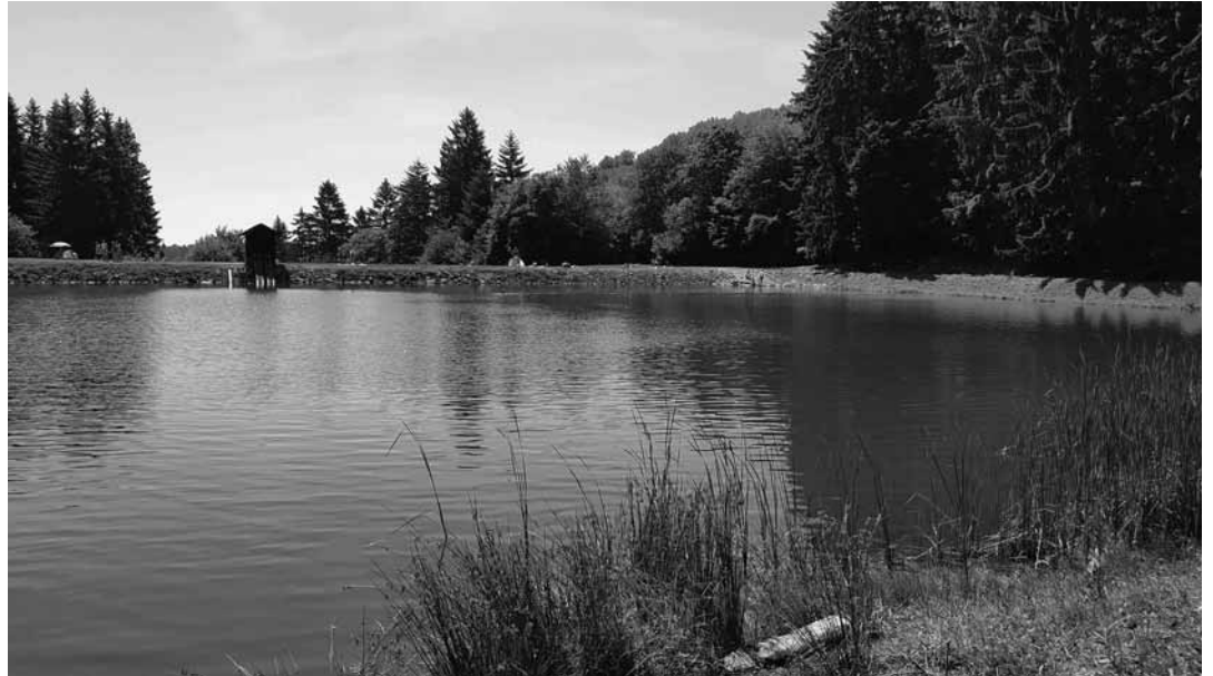
Vodná nádrž Velká Vodárenská - najstarší tajch s tyrkysovou vodou FOTO PETER KOLEDA
