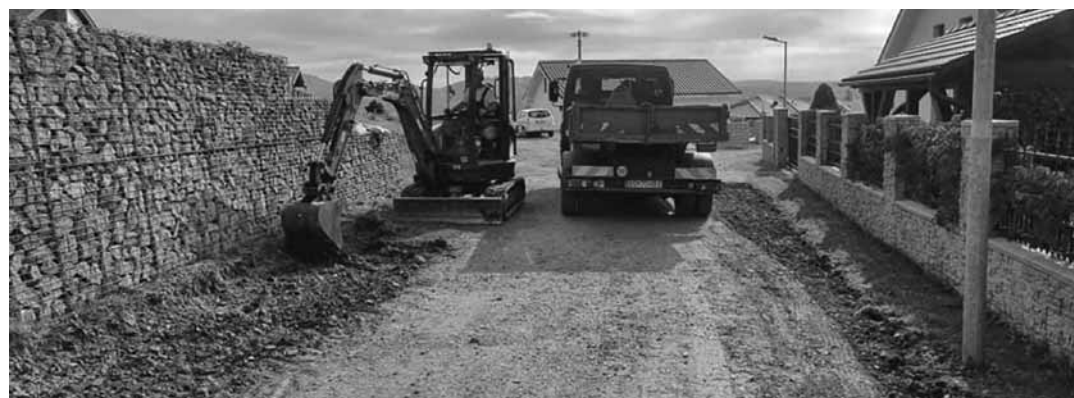
Stavebné práce na komunikácii Ul. SNP FOTO ARCHÍV MsÚ
