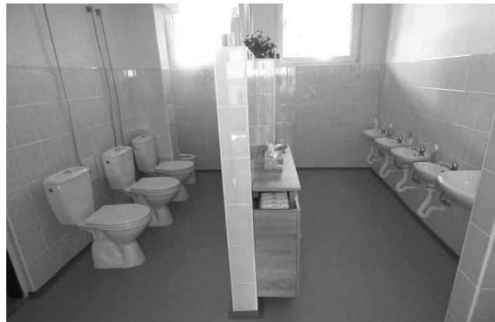
Vynovené sociálne zariadenia FOTO ING. JURAJ CHRENKO
