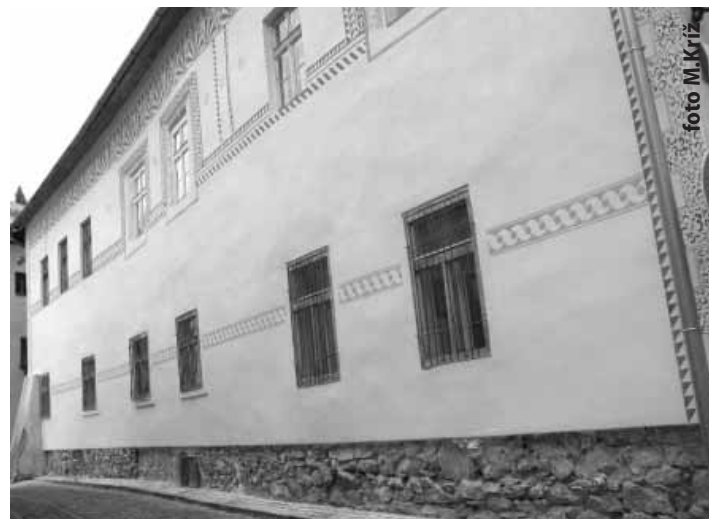
Cirkevný zbor ECAV v Banskej Štiavnici sa pravidelne stará o svoje historické budovy v centre mesta a tak aj v tomto roku sa podarilo obnoviť časť fasády na budove lekárne Lumitzerov dom.
