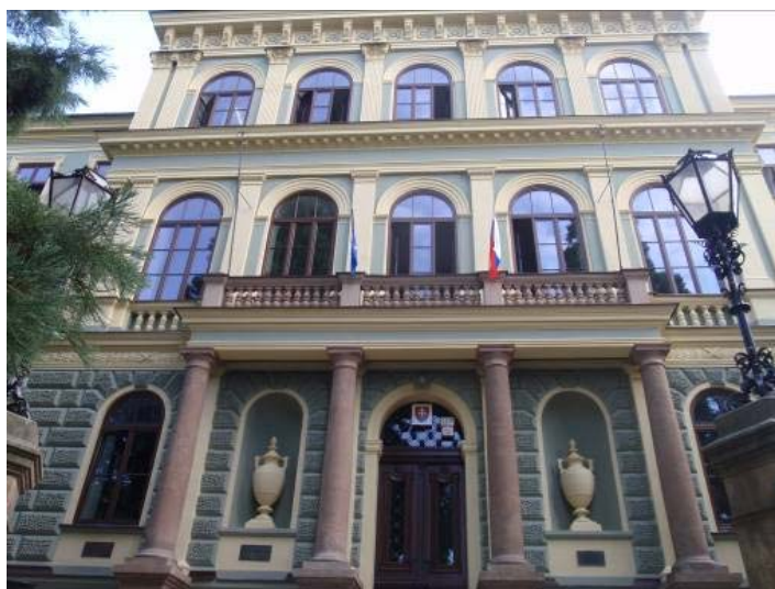
Zrekonštruovaná čelná fasáda školy. FOTO JANETTA HUDECOVÁ
