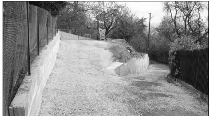
Nové oporné múry na Kukučínovej ulici FOTO M. RUŠČÁK
