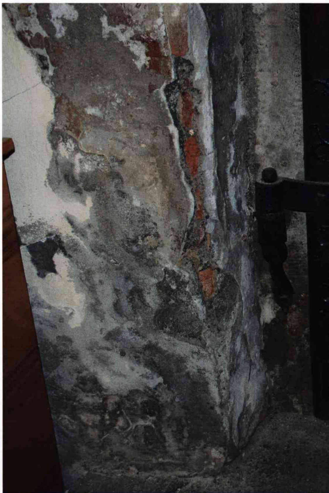
Technický stav južnej steny napravo od vstupu vykazujúci vysoký stupeň zasolenia
