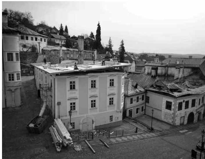
Rekonštrukčné práce Szitnanyovského domu FOTO J. PETRIK 2.str.
