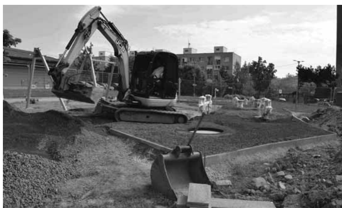
Budovanie detského ihriska FOTO MICHAL KRÍŽ
